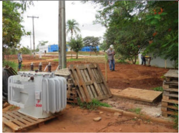
Autor: AMAE Descrição: Obra da subestação na ETA Abóboras.
