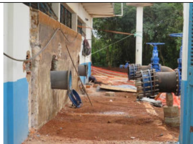
Autor: AMAE Descrição: Bombas aguardando instalação do flange.
